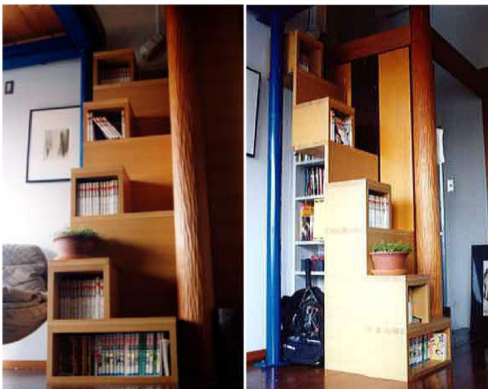
増築した部屋への階段式本棚の正面(右上に床の一部が見えます)
