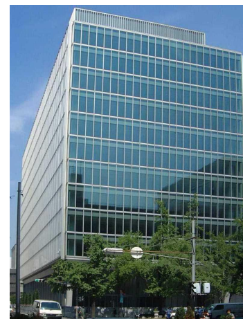
大阪明治生命館・東南面外観
