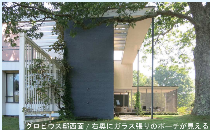
グロピウス邸西面 / 右奥にガラス張りのポーチが見える
